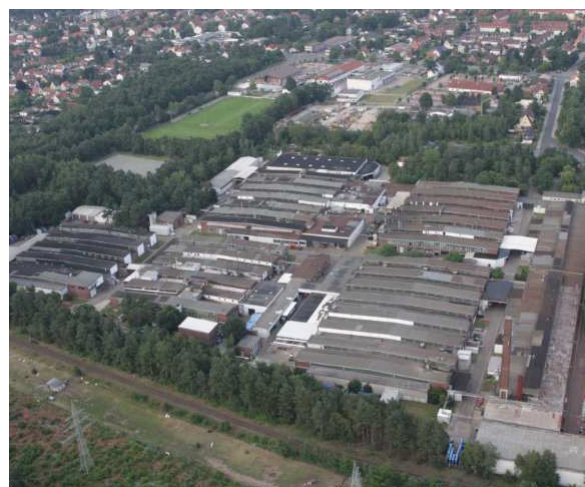
47 Blick auf das Continental-Gelände
