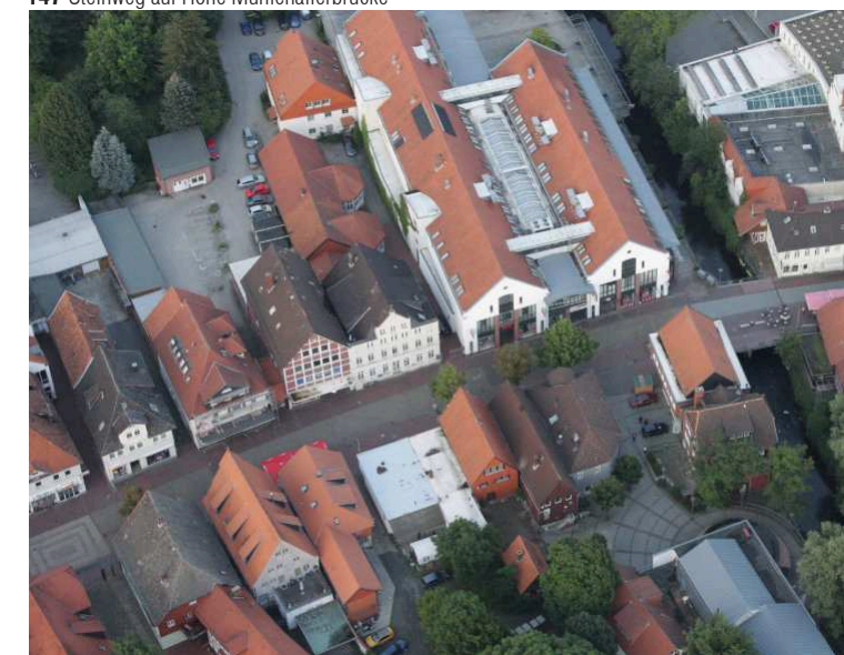
147 Steinweg auf Höhe Mühlenallerbrücke
