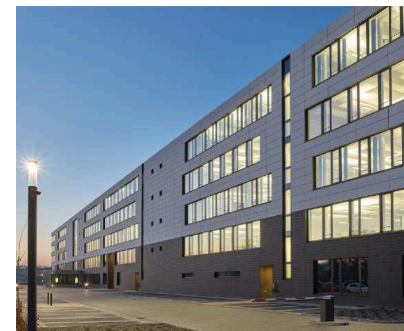
49 Neubau IAV (Protec Planungsgesellschaft mbh 2022)
